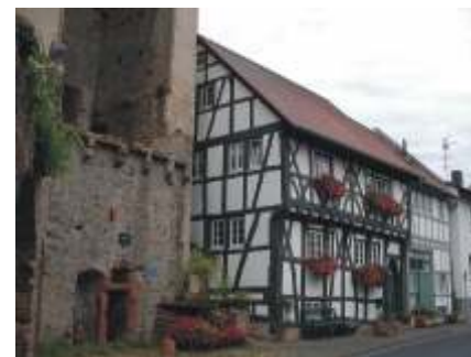
Babenhausen, Am Hexenturm 22 Fachwerkhaus von 1460. Typus des gotischen Ständerbaus als sog. Hallenhaus. Sanierung unter Einbezug der benachbarten Scheune, Berücksichtigung bzw. Wiederherstellung der historischen Raumgrößen und -zuordnungen.
