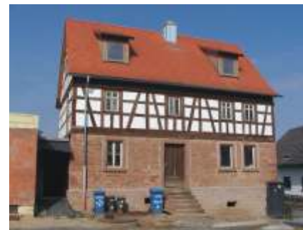
Ober-Klingen, Im Eck 1 Hofreitenanlage mit dreizonigem Wohnhaus von 1841, Sanierung im Bestand
