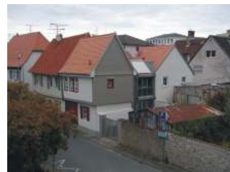
Dieburg, Eulengasse 11 Kleines Fachwerkhaus kurz nach 1545. Gemeinsam mit der rückwärtigen Scheune saniert, Integration des Innenhofes in den Grundriss.
