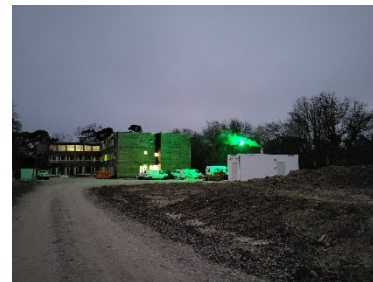
Baustelle mit Bauwatch-Beleuchtung und laufender Heizung
