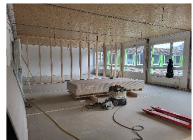
Ausbau im 2. OG
