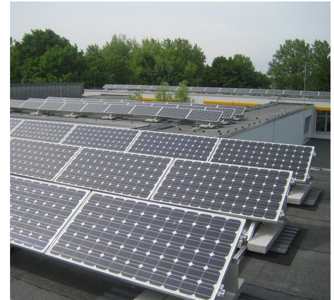
Die erste Photovoltaikanlage ist auf der Hähnleiner Grundschule in Alsbach-Hähnlein im Dezember 2007 in Betrieb gegangen. Mit einer Leistung von 29,7 kWp sorgt sie für eine CO<sub>2</sub>-Einsparung von 14,85 Tonnen CO<sub>2</sub> pro Jahr.
