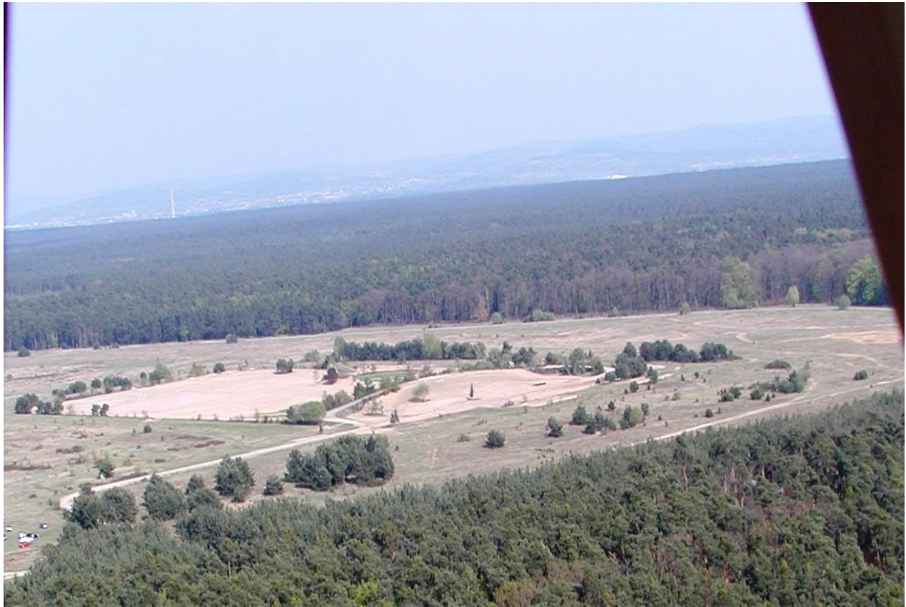
Ehemalige Patriotstellung nach Rückbau 2009
