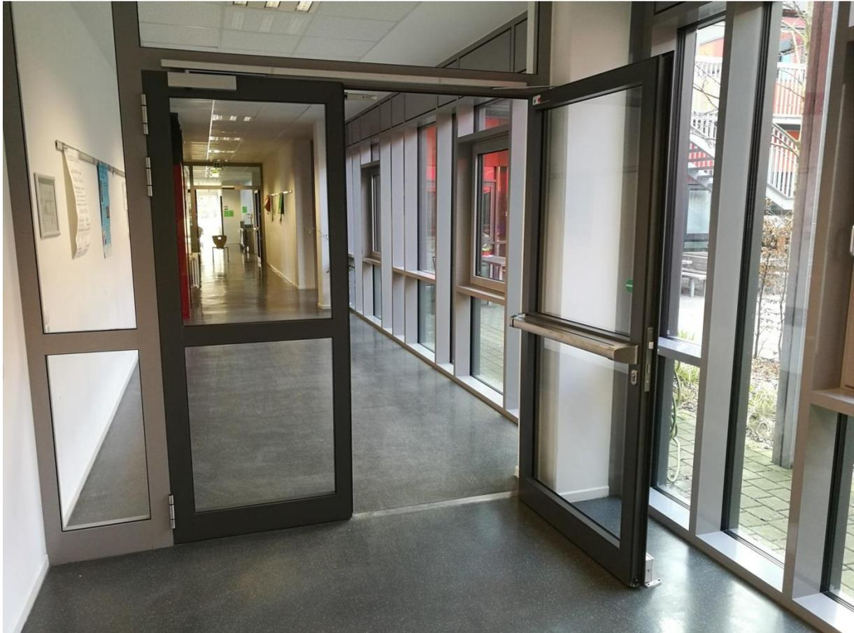
Abbildung 10 - Brandschutztür mit Feststelleinrichtung (schließt im Brandfall automatisch)
