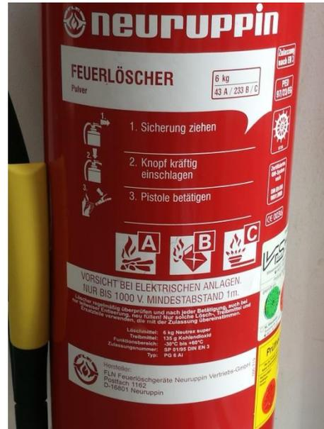
Abbildung 9 – Bedienungsanleitung Feuerlöscher
