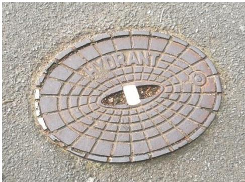
Abbildung 4 - Unterflurhydrant
