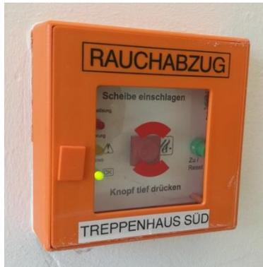
Abbildung 11 - Druckknopf Rauchabzug mit Beschriftung der Lage des Rauchabzuges
