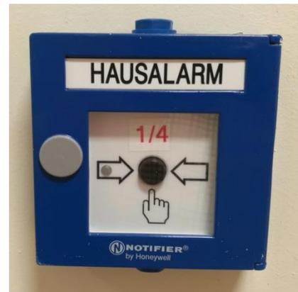
Abbildung 6 - Druckknopfmelder Hausalarm und Alarmierung Feuerwehr    Abbildung 7 - Druckknopfmelder Hausalarm
