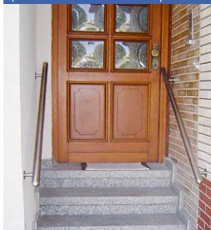
Treppe im Eingangsbereich nachher (Handläufe auf beiden Seiten)
