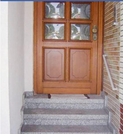
Treppe im Eingangsbereich vorher
