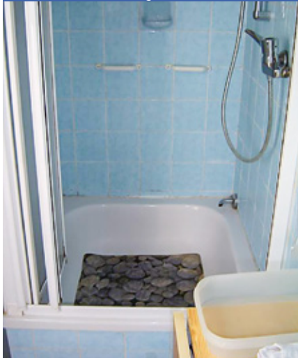
Dusche vorher: mit hohem Einstieg
