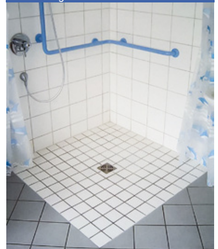
Dusche nachher: ebenerdig
