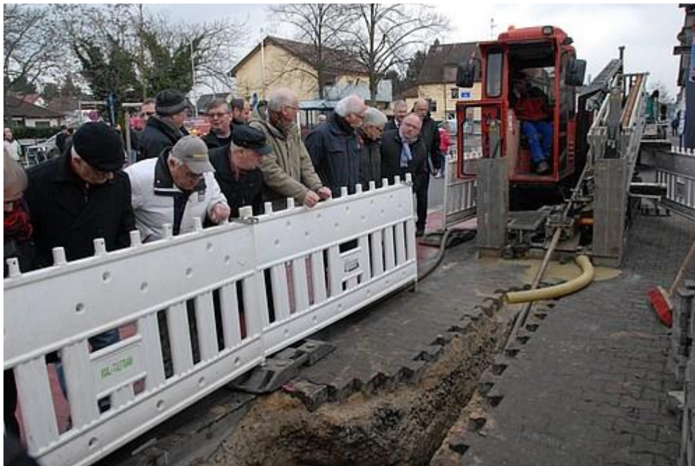
Auf großes Interesse stieß das von der Firma Klenk angewandte Spülbohrverfahren.
