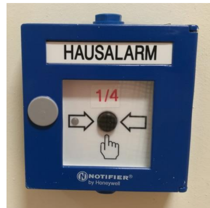
Abbildung 7 - Druckknopfmelder Hausalarm
