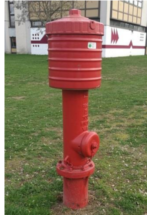
Abbildung 3 - Überflurhydrant
