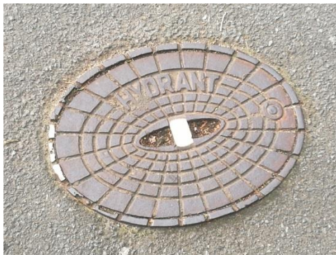
Abbildung 4 - Unterflurhydrant
