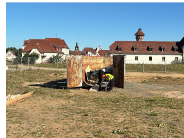
temporäre Zwischenlagerung von Bauschutt im Zuge der Entkernungs- und Teilabbrucharbeiten des Bestandsbaus
