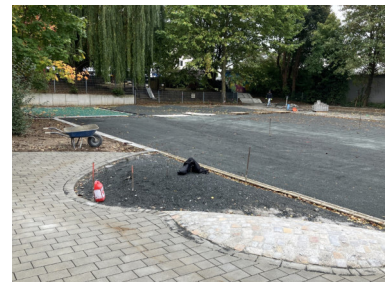
Vorbereitetes Schotterplanum für EPDM-Beläge im Bereich der Weitsprunganlage
