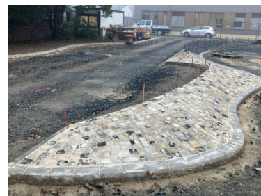
fertiggestellte Intarsien-Beläge im Randbereich der 3-spurigen Laufbahn
