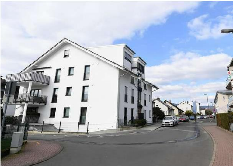
Ärgernis für die Nachbarn: Der platzgreifende Neubau in der Obergasse 28. Jens Priedemuth © Jens Priedemuth
