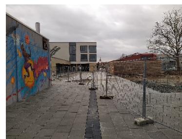
Pflasterfläche vor Sporthallen
