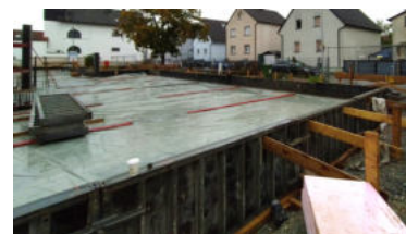
Betonierarbeiten Bodenplatte Neubau
