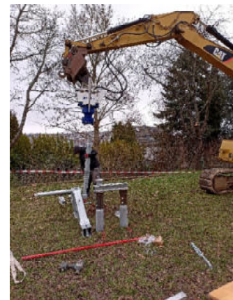
Erstellung der Schraubfundamente
