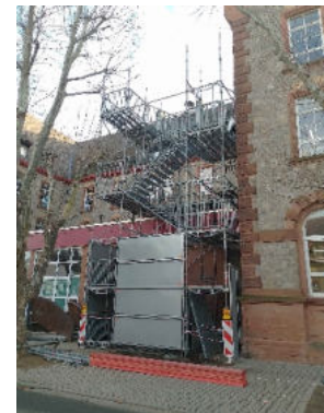
Fluchttreppe A-Bau, Südflügel
