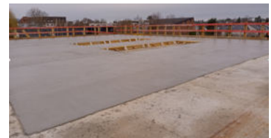
Oberste Geschossdecke Bauteil 0
