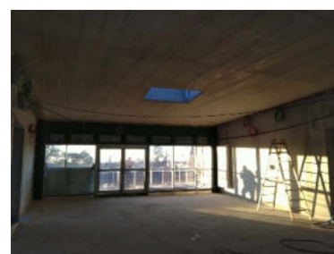
Blick auf Erschließungsfläche zwischen den Clustern im 2. OG
