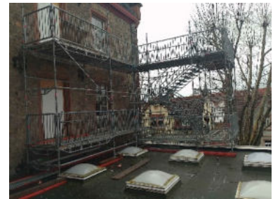
Anschluss Fluchttreppenturm, A-Bau
