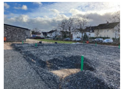
Vorbereitung für den Gebäudestandort
