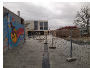
Pflasterfläche vor Sporthallen
