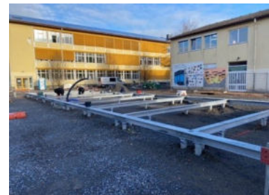
Baugelände Richtung Norden
