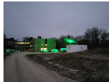
Baustelle mit Bauwatch-Beleuchtung und laufender Heizung
