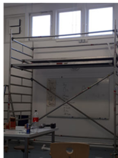
Montagegerüst Stephan-Gruber-Schulen Eppertshausen
