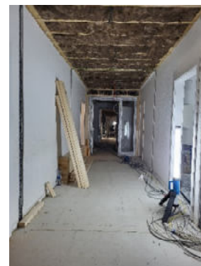
Flur im 2. OG
