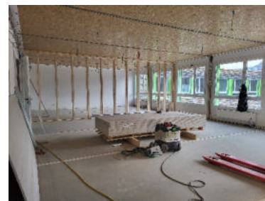
Ausbau im 2. OG
