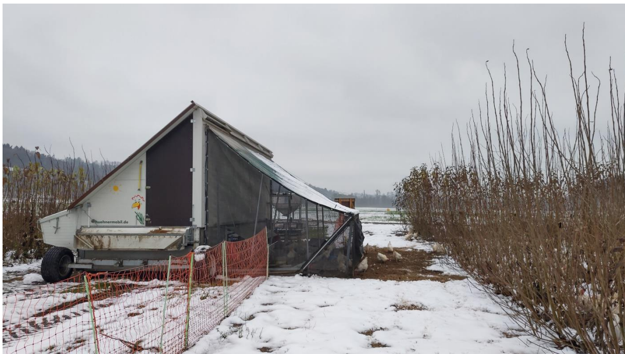
Abb. 1: Kleiner Mobilstall mit angehängtem Wintergarten aus Plane und Windschutznetz mit eingebauten Stangen zur Stabilisierung im Winter (Schneelast)
