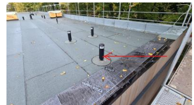
Fertigstellung Dachabdichtung
