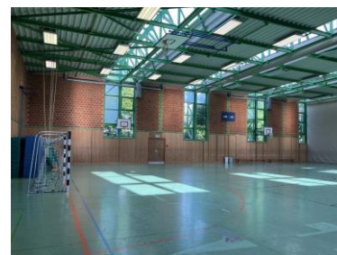
Innenansicht Bestand, Stand September 2025
