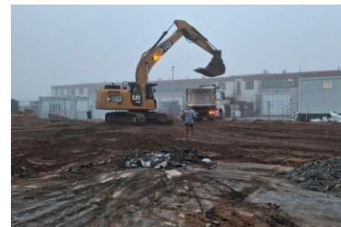
Abbruch- / Schadstoffsanierung (Baugrundstück allgemein)
