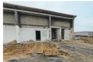
Abbruch- / Schadstoffsanierung (Bestandsbau Fassade)
