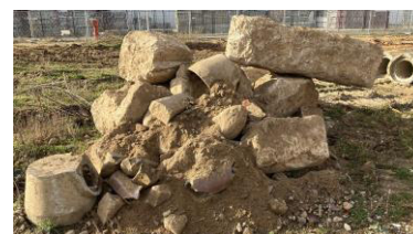
Vorgefundene Fundamentreste im Zuge der Aushubarbeiten Tiefbau
