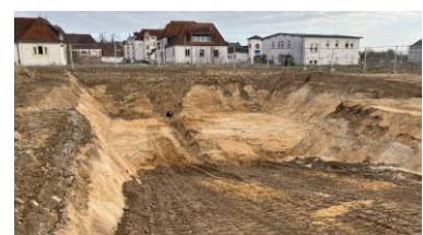
Baugrube "Rigole" (Blickrichtung Norden)
