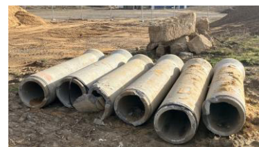
Abgebrochene, undokumentierte Kanal- / Bestandsleitungen
