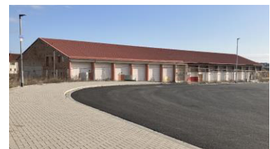
Bestandsbau - Südfassade (Öffentlicher Straßenraum)
