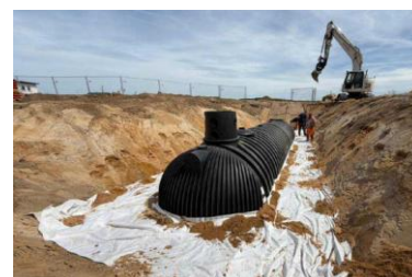
Einbau und Verfüllen Zisternenkörper zur Regenwassernutzung
