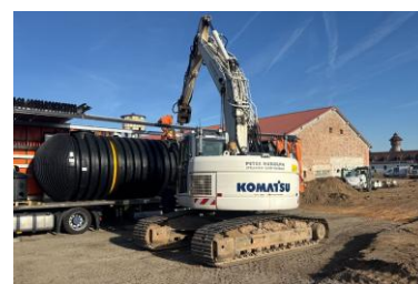
Anlieferung Zisterne / Regenwassertank (Volumen: 46.000 Liter)
