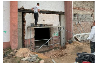
Notwendige Wandöffnung mittels Sturzkonstruktion (Stahlträger) in Bestandsmauerwerk
