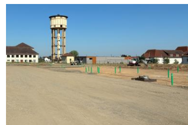
Fertiggestellte und geplante nördliche Baustellenfläche (Bereich Neubau)
