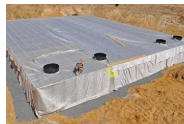
Eingebaute Blockspeicher-Rigole in mehrlagiger Bauweise mit allseitiger Trenn-, Schutz- und Filtervlieslage
