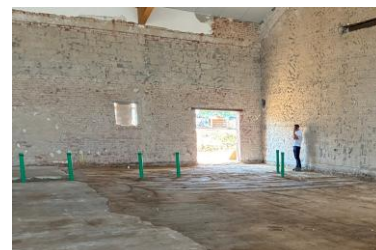
Abzweig- / Grundleitungen innerhalb des Bestandsgebäudes, einschließlich partiellen Abbruch und Wiederverfüllung der Bodenplatte
