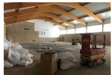
Turnhalle - Entfernen Innenputz
