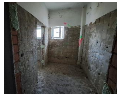
Kinobereich - Sanitärräume nachher
