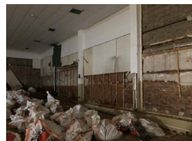
Kinosaal - Ausbau Wandverkleidungen
