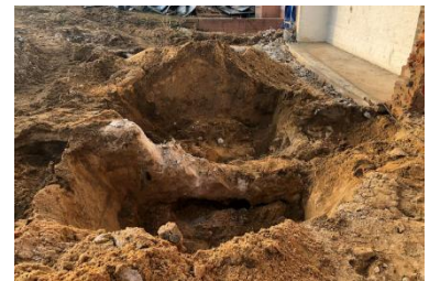
Ehem. Kegelbahn - Ausbau Fundamente
