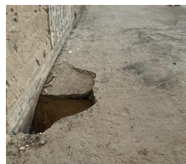
Zu untersuchende Bodenplatte
