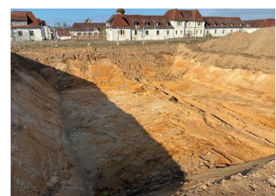
Bereich der Rigole
