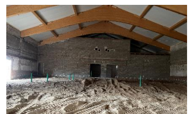
Verlegte Installation ehem. Kinobereich
