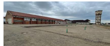
Baustelleneinrichtungsfläche, bereits planierter Bereich Neubau
