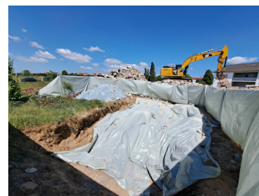
Asbestfund unter einer Bodenplatte
