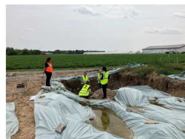
Asbestfund unter einer Bodenplatte
