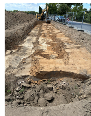
Erdarbeiten zur Entsorgung der vorgefundenen Schuttschicht
