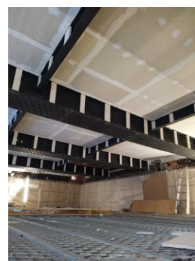
A-Bau: Decke Aula
