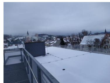
Dach Z-Bau saniert inkl. Blitzschutz
