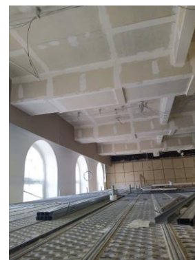
A-Bau: Aula (EG)
