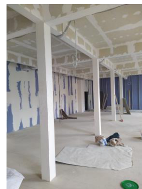
A-Bau: Lehrerzimmer (1. OG)
