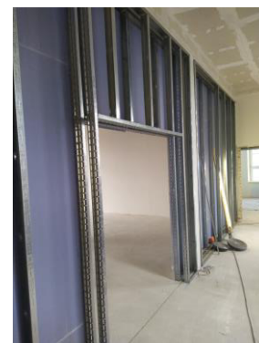
A-Bau: Türöffnung Musikraum A27 (2. OG)
