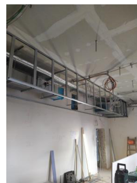
A-Bau: Klassenraum A05 (EG)
