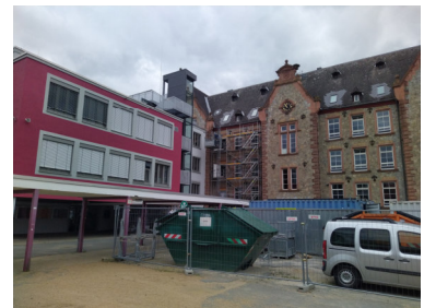
Ansicht A- und Z-Bau
