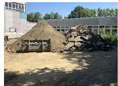
Tiefbauarbeiten: Aufbruch alte Asphaltdecke Schulhof und Aushub
