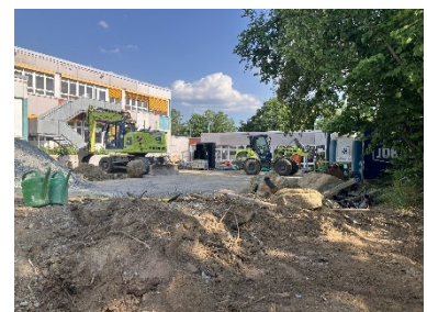
Start der Tiefbauarbeiten
