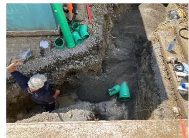
Tiefbauarbeiten: Verlegung Regenentwässerung
