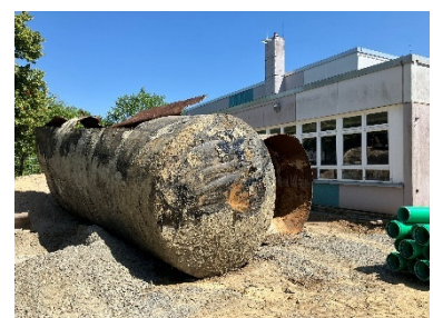
Tiefbauarbeiten: geborgener Öltank
