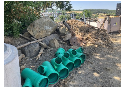
Tiefbauarbeiten: geborgene alte Leitungen und Felsgestein
