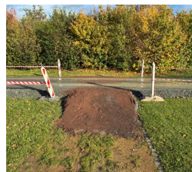
Überquerung Baustraße für Friedhofsbesucher
