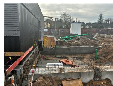
Fundamente, demontierte Fassade
