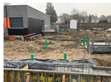
Kanal- und Tiefbauarbeiten
