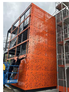
Montage Verkleidung am Außentreppenturm
