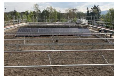
Vorbereitung Dachbegrünung und Montage PV-Module
