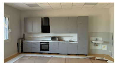
Küchenzeilen in den Klassenräumen
