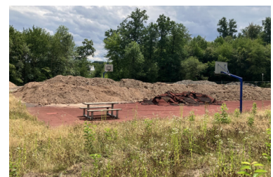
Ehemaliger Außensportbereich als Fläche für Erdaushub und Zwischenlagerung
