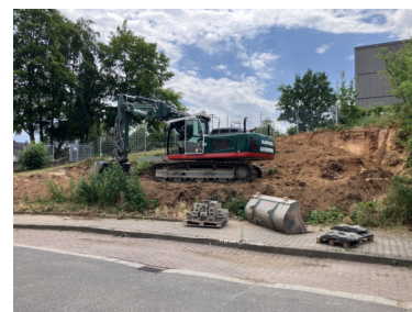
Aushubarbeiten für Rückhaltebecken zur gedrosselten Einleitung Kanalisation (Straßenraum "Langstädter Straße")
