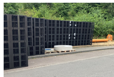
Gelieferte Block-Rigolenfüllkörper zum modularen, mehrlagigen Einbau (Rückhaltebecken)
