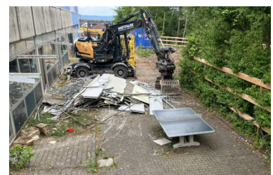
Abbrucharbeiten entlang südöstlicher Fassade Hauptgebäude
