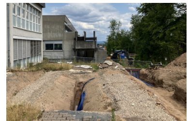
Grabenarbeiten Thermosondenfeld (südöstlicher Grundstücksbereich)
