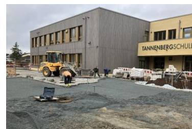
Pflasterbelagsarbeiten Haupteingangs- / FW-Durchfahrtsbereich
