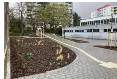
Abgeschlossene Pflanzarbeiten (FW-Durchfahrt)
