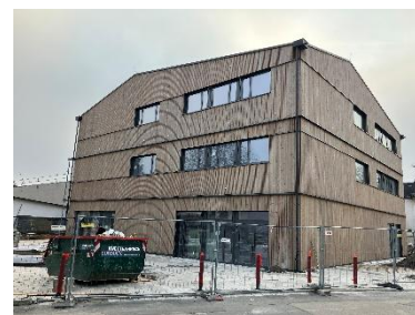
Neubau aus Richtung Lindenstraße
