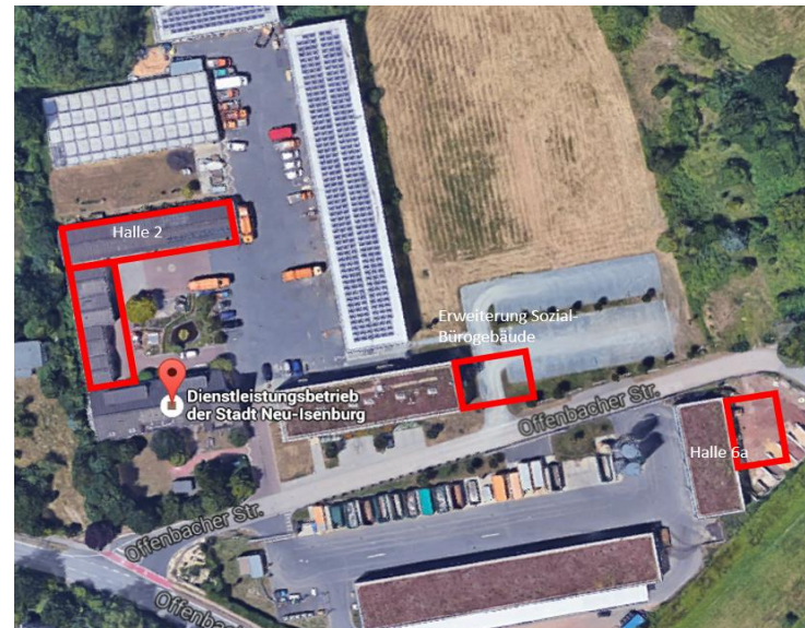
Begrünung der Dächer mehrerer Gebäude auf dem Betriebs-hof des Dienstleistungsbetriebes der Stadt Neu- Isenburg
