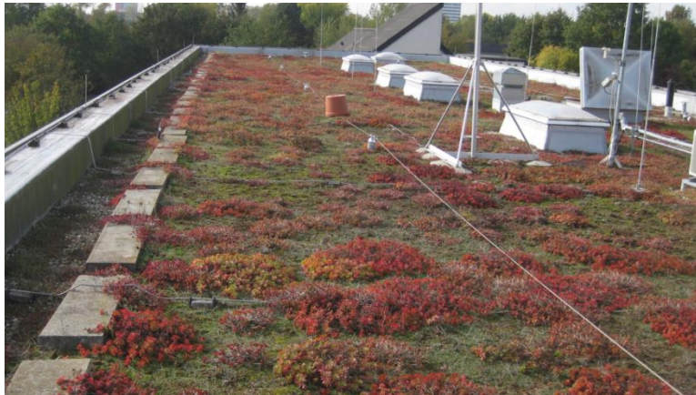
Dachbegrünung auf bestehendem Büro- und Sozialgebäude
